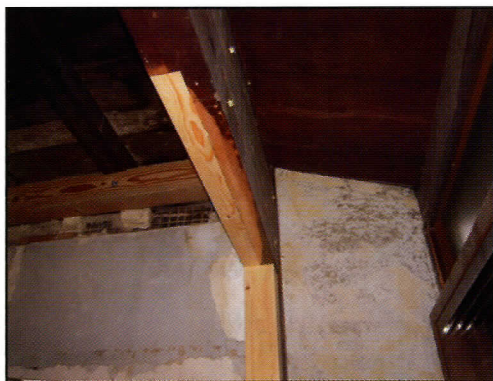
雨漏り個所の梁継ぎ足し
