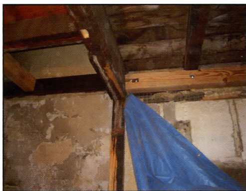
雨漏り箇所梁補強
