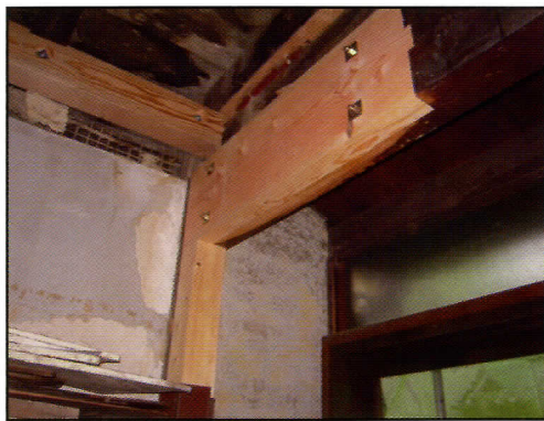
雨漏り個所の梁継ぎ足し
