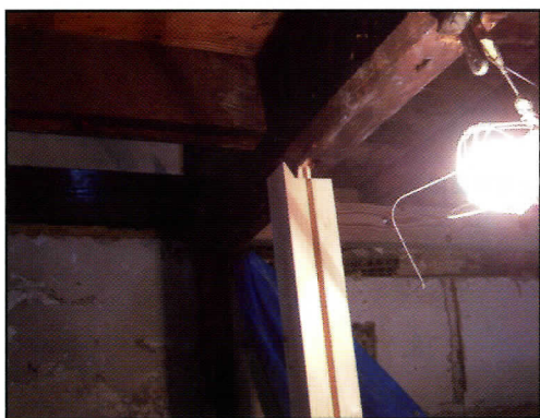
部屋割り変更の柱挿入
