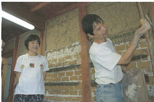
写真 3-1-3① 目地に漆喰を埋め込む(筆者撮影)
