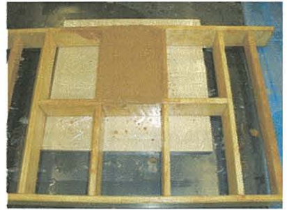
写真 4-3⑧ 型枠の上に出ている藁を中に入れ込む
