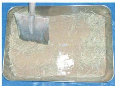
写真 4-3③ 土と藁を混ぜ合わせる
