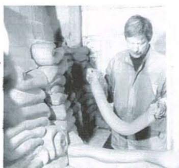
図 3-1-1⑥ 練り土を積み上げる
