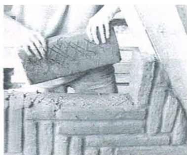
図 3-1-1⑬・⑭ 間柱間には練り土を加工し積み上げる
