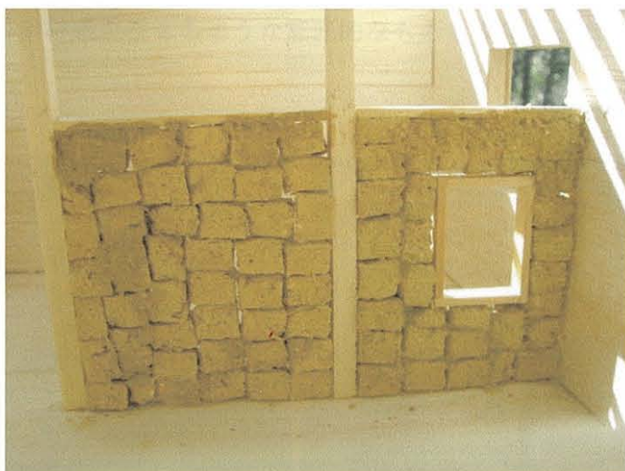
写真 4-5-4⑨ 間仕切り壁 レンガの間にフレームを作成 (筆者撮影)
