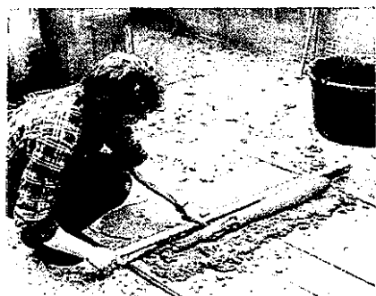
図 3-1-1⑧ 細い棒状の木に練り土を巻き付ける
