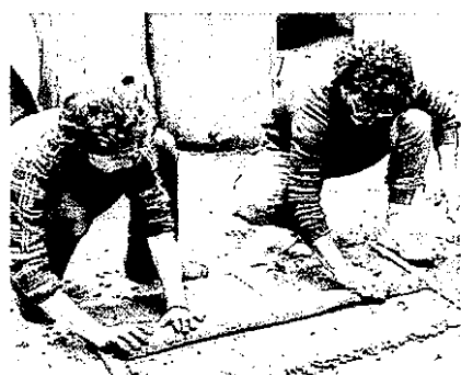
図 3-1-1⑨ 回転させながら練り土を巻き付ける
