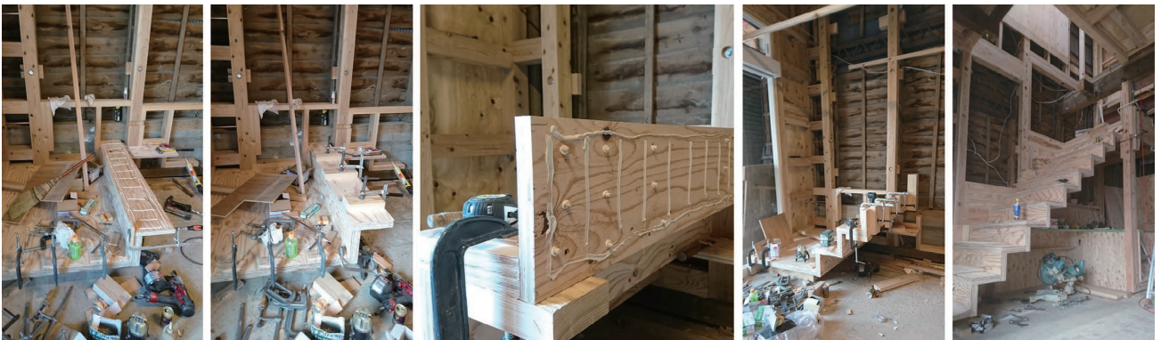
写真11 階段施工のプロセス（積層）
