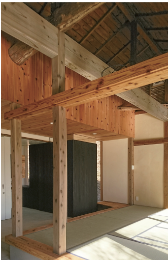
写真6 構造補強して整理された小屋組
